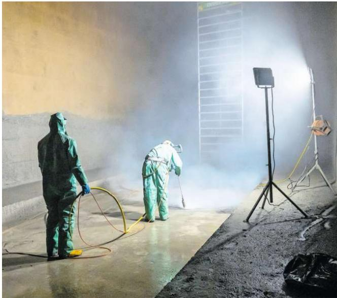
Arbeiter sind in der Wasserkammer mit Hochdruckreinigern am Werk.
