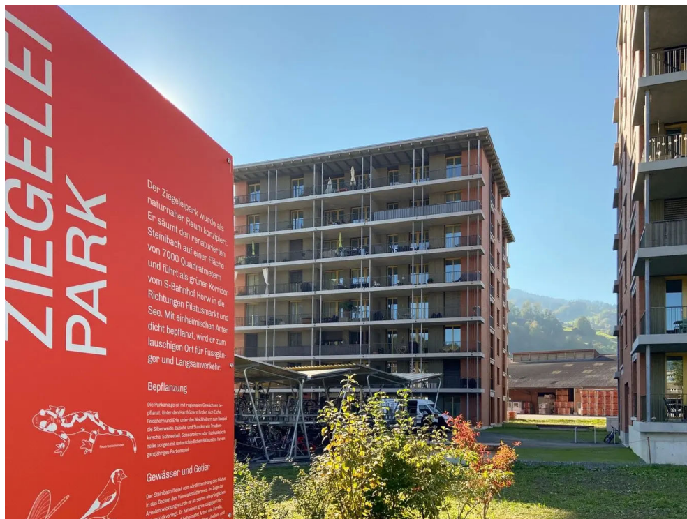
Ein Teil der ersten Bauetappe im Ziegeleipark.
