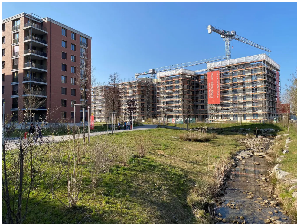
Rechts das Haus Ziegeleiweg 2–5, links ein Gebäude der ersten Bauetappe. Bild: hor (Horw, 23. März 2022)
