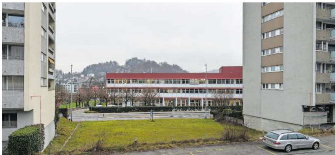
Hier sind Studentenwohnungen geplant. Hinten: die Hochschule. Bild: Dominik Wunderli (Horw, 5. Januar 2021)
