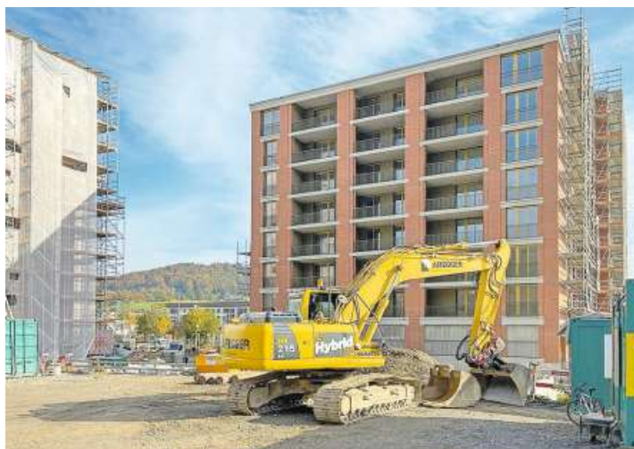
Eines der drei achtstöckigen Häuser der ersten Bauetappe ist bereits vom Gerüst befreit.
